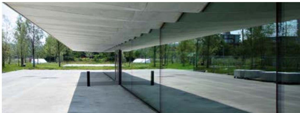
Die bis zu zehn Meter auskragenden Balkone aus Liapor-Leichtbeton strukturieren die Gebäudehülle.
