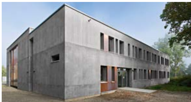
Die Lochfassade greift die Wehrhaftigkeit und Beständigkeit der angrenzenden Trutzburg auf.
