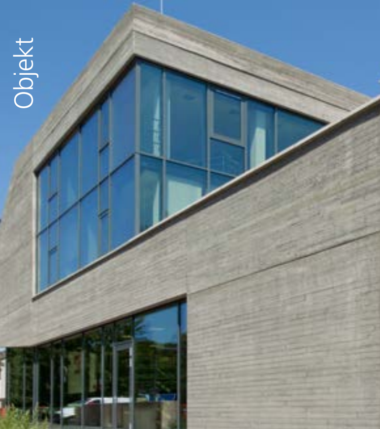
Die Fassade aus sandsteinfarbenem Liapor-Leichtbeton wurde einschalig mit der charakteristischen, rauen Brettschalung ausgeführt.
