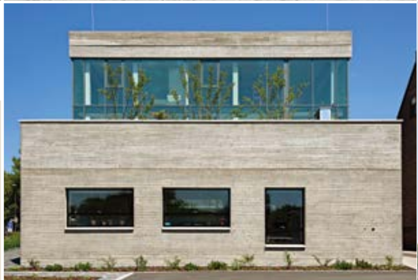
Die Fassade aus sandsteinfarbenem Liapor-Leichtbeton wurde einschalig mit der charakteristischen, rauen Brettschalung ausgeführt.
