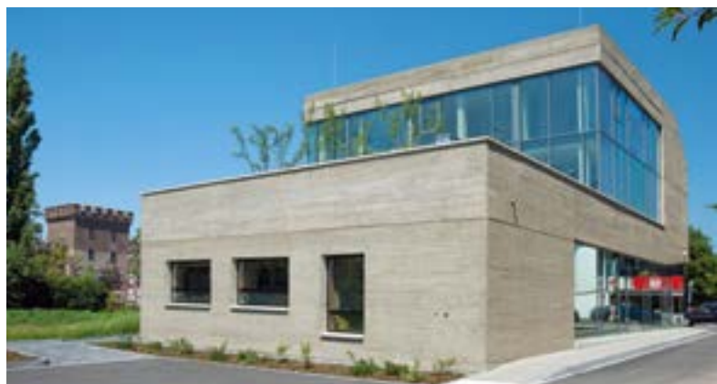
Der monolithische Charakter des Bürgerbüros steht in engem Kontext zum historischen Bonner Tor.
